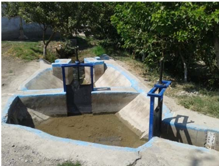
Фермерское хозяйство «Кахрамон Давлат Саховати», Гидротехническое сооружение для подачи и замера подачи воды
